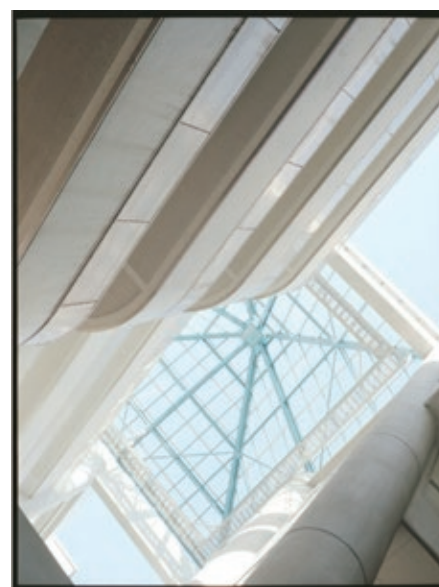
天久保キャンパスコミュニケーションホールガラス屋根 Glass roof, Communication Hall, Amakubo Campus
