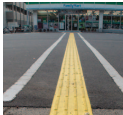
敷設された点字ブロック
