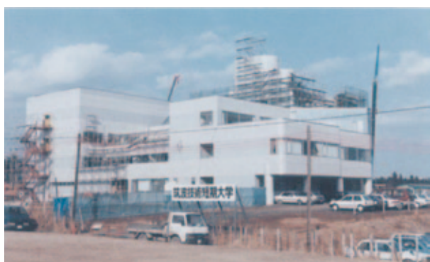
校舎建設の様子
